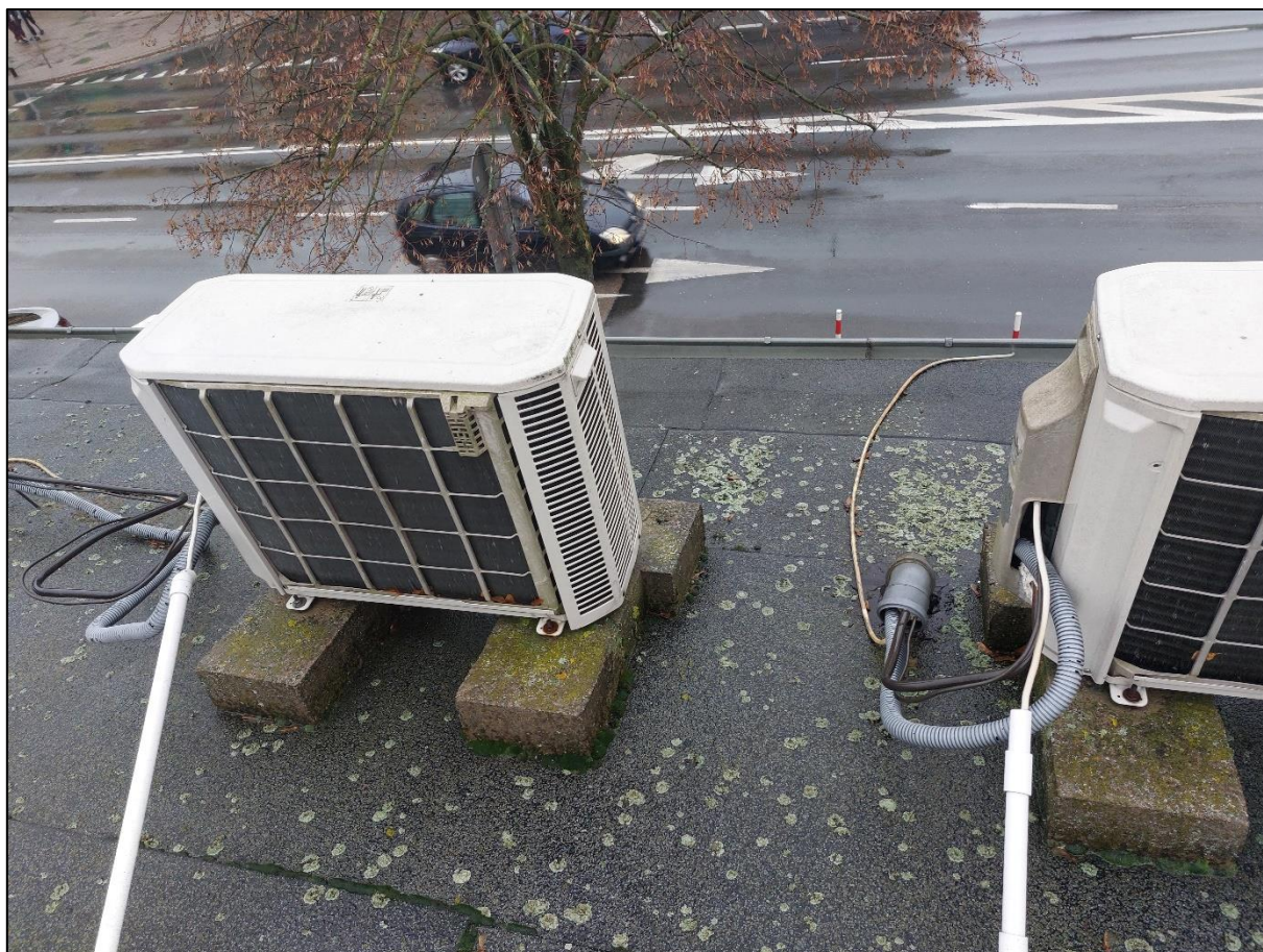
Fot. 132 - PODSTAWY+ZASILANIE, LUŻNE PRZEWODY
