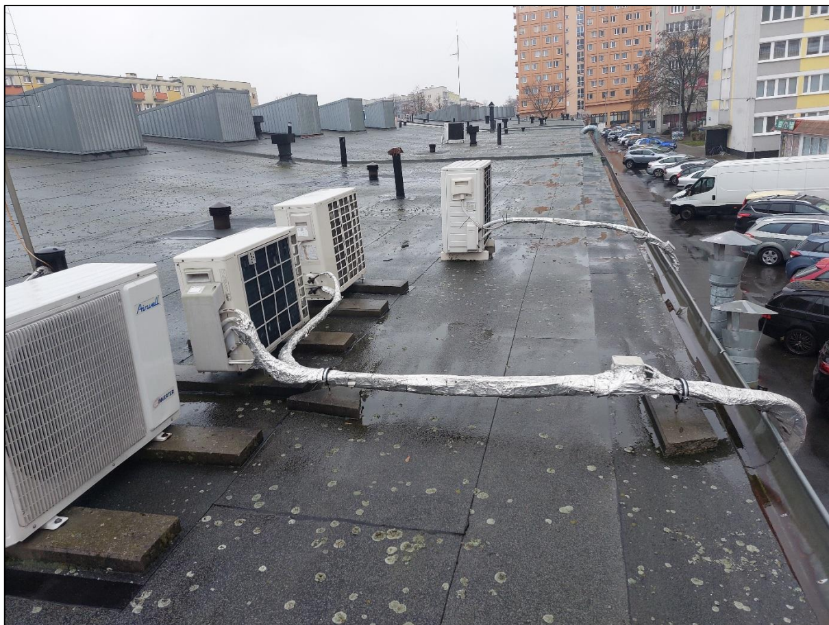
Fot. 146 – BRAK OSŁON PRZEWODÓW
