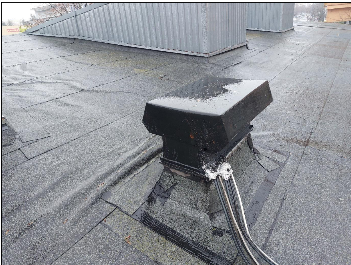
Fot. 144 – BRAK OSŁONY PRZEWODÓW
